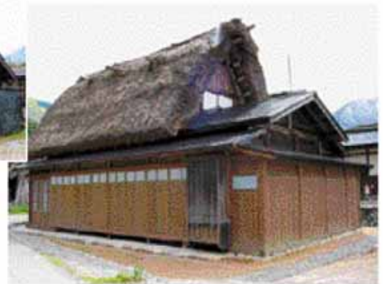
竣工：北東側(北側落屋トタン壁を板壁に修景)
