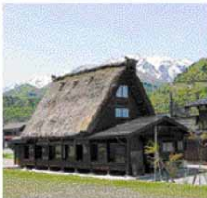
竣工：北東側 落屋の棟高が下がり合掌妻壁が見えるようになった
