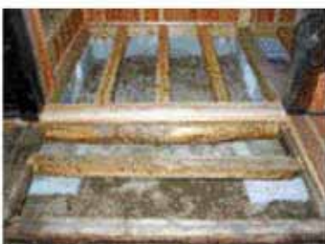
修理後：新しいクリ材と取り替え、独立基礎で床下の懐を確保した
