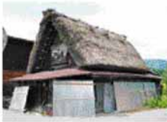
修理前：南東側
