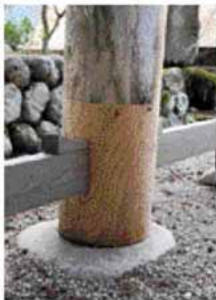
竣工：根継(金輪継) 当初材と同種のケヤキ材で根継ぎ
